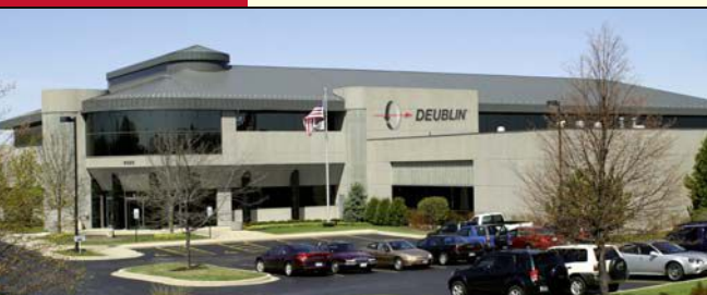
Наш центральный офис в Ваукегане (Иллинойс, США)
